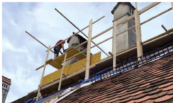
Im Nordtrakt der Basilika Graz-Mariatrost wurden kürzliche die Dachziegel „überklaubt“ und die Kamine saniert. Das „Dach für den Segen“ ist wieder voll funktionstüchtig und dicht!
